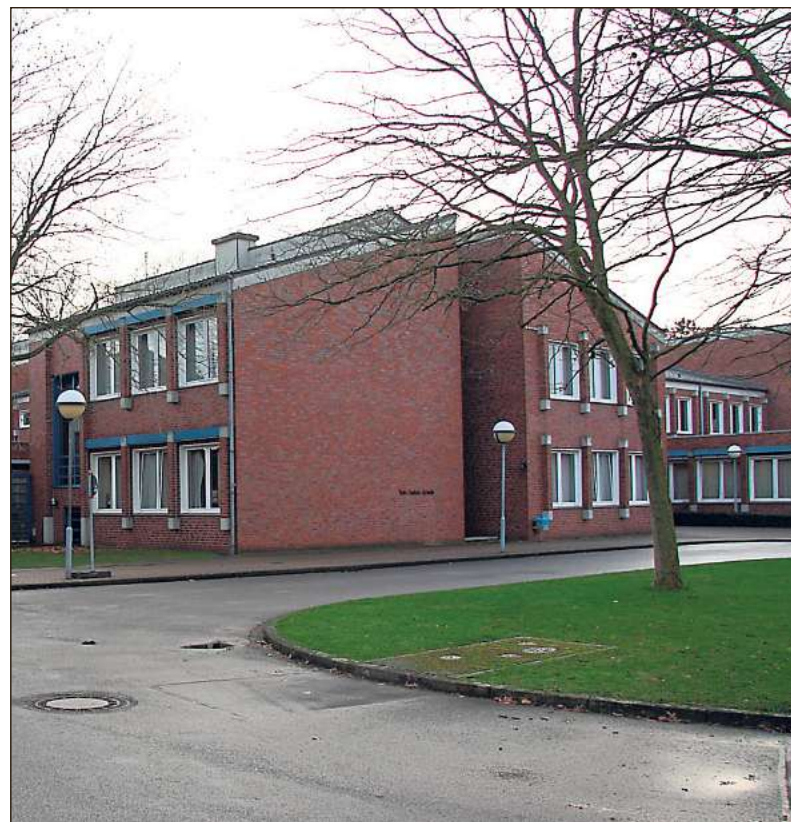
Ein Gebäude, das symbolisch für zwei große Themenschwerpunkte steht: Die ehemalige Hauptschule beherbergt bis zum Sommer eine Flüchtlingsnotunterkunft und soll zum Grundschulgebäude umgebaut werden. Bild: Stempfle
