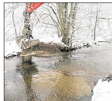
**Im Fluss Este** in der Lüneburger Heide wurden Lenkbuhnen aus Kies und Geröll eingebaut...
